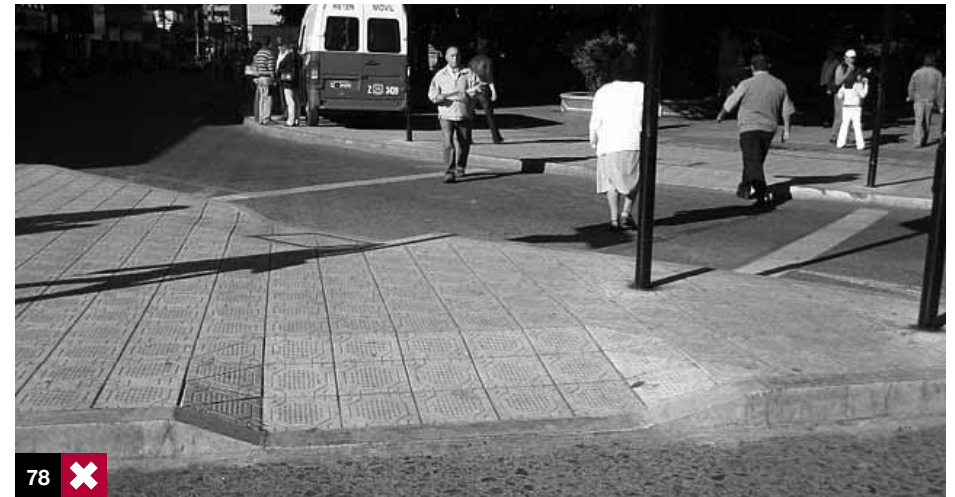
Foto 78: los pasos intermedios deben ser a nivel con la calzada y mantener el mismo ancho que la demarcación del cruce. El que se muestra en la foto exige un exceso de esfuerzo a una persona en silla de ruedas para lograr el cruce. Temuco, Chile.
