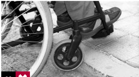
Foto 29: rebaje no practicable, mal diseño por diferencias de nivel entre vereda y calzada.
