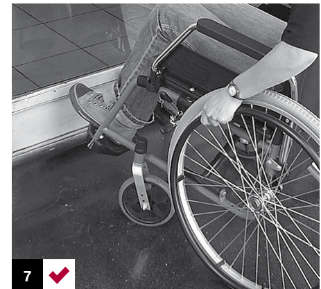
Foto 7: las puertas vidriadas requieren una protección a la altura de los apoya pies para evitar golpes en el vidrio.
