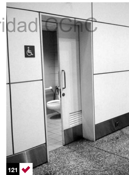
Foto 121: puerta corredera para acceso a baño de diseño universal. Shanghai, China.
