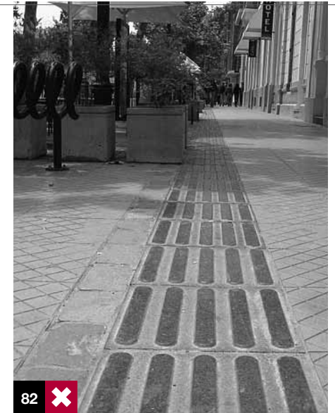
Foto 82: guía de avance seguro obstaculizada por jardineras y otros elementos, convirtiéndola en un peligro para personas ciegas. Santiago, Chile.
