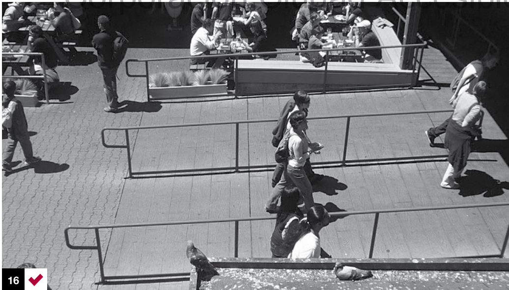
Foto 16: el principio de igualdad en el uso del diseño universal se manifiesta en este cambio de nivel solucionado con rampas. San Francisco, EE.UU.
