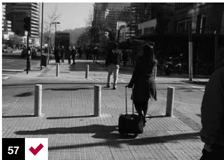
Foto 57: pilotes distanciados que permiten la continuidad en la circulación peatonal. Santiago, Chile.
