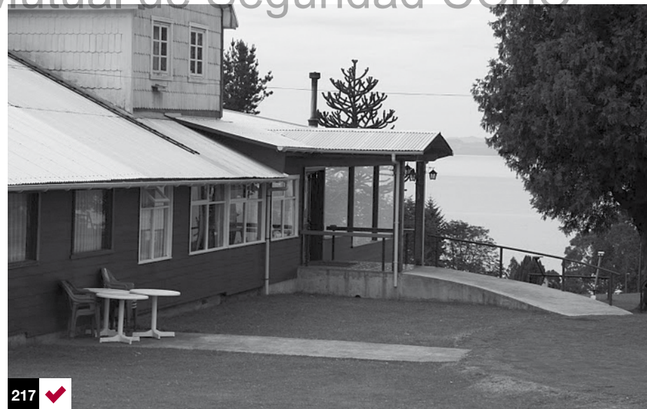
Foto 217: restaurant turístico que adaptó su acceso para sus clientes con dificultades de desplazamiento. Lago Llanquihue, Chile.
