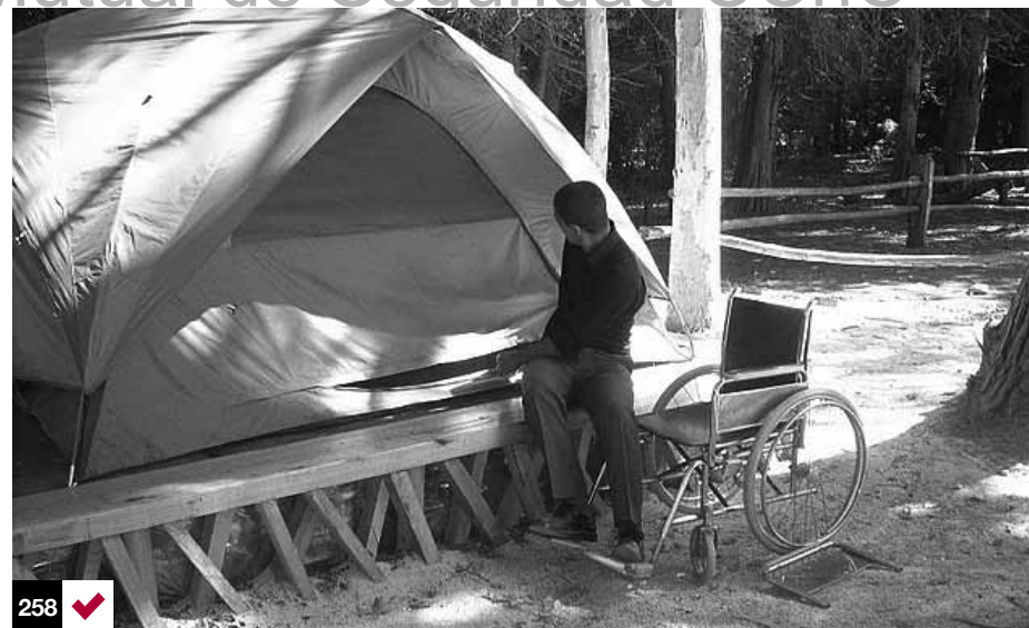
Foto 258: base para montar una carpa que permite una transferencia cómoda desde la silla de ruedas. Reserva Federico Albert. Chanco, Chile
