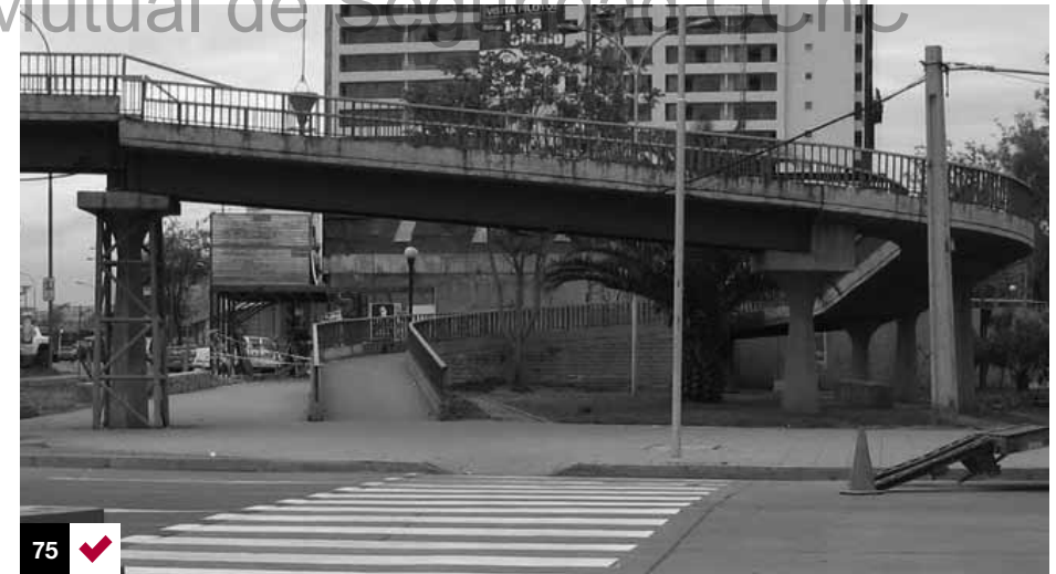
Foto 75: pasarela peatonal sobre autopista con accesos universales de uso. Santiago, Chile.
