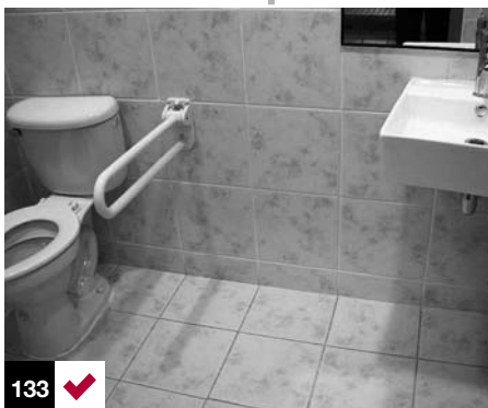
Foto 133: baño con espacio de transferencia lateral adecuado.
