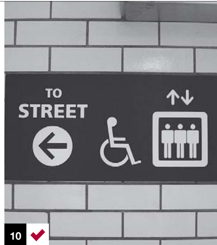
Foto 10: se debe señalizar en itinerario de salida peatonal accesible. Nueva York, EE.UU.
