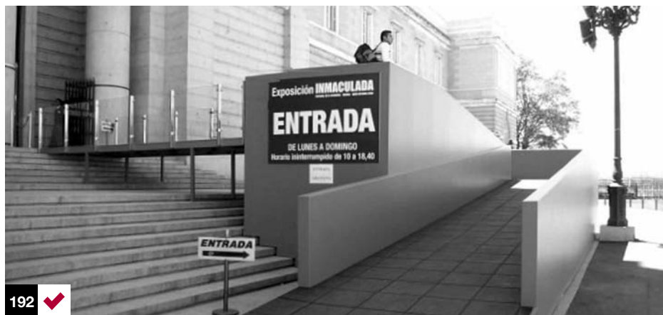
Foto 192: rampa mecano removible en el acceso a la catedral de Santa María la Real de la Almudena. Madrid, España.
