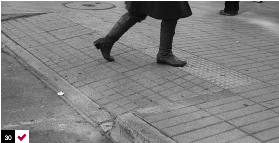
Foto 30: rebaje correcto, se igualan los niveles entre vereda y calzada. El ancho corresponde a todo el cruce peatonal. Santiago, Chile.
