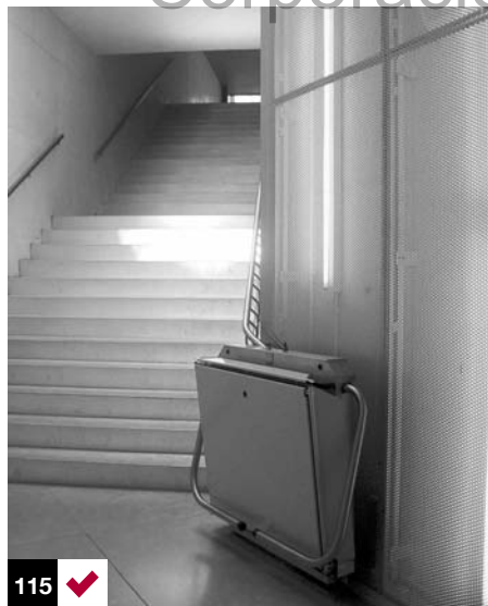
Foto 115: salvaescalera con plataforma en adaptación de edificio antiguo. Oporto, Portugal.
