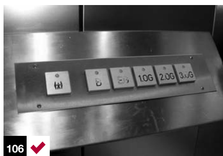
Foto 106: botonera horizontal de fácil alcance y detección.
