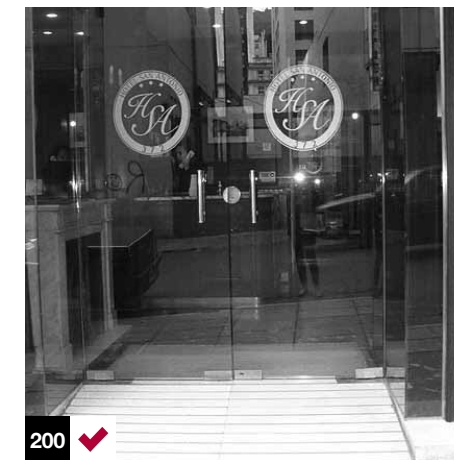
Foto 200: eliminando un peldaño se adaptó el acceso al hotel. Buenos Aires, Argentina.
