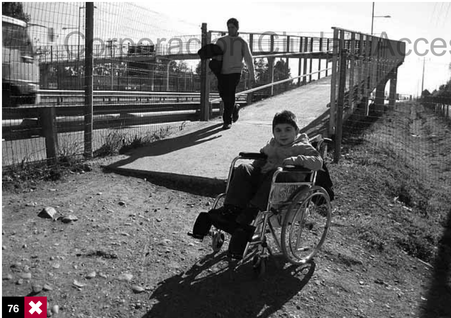
Foto 76: pasarela peatonal en autopista 5 Sur sin un circuito peatonal adecuado para alcanzar las rampas. La cadena de accesibilidad se rompe inutilizando el uso. Paine, Chile.
